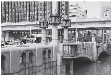
重要文化財にも指定される大江橋(上流側)
